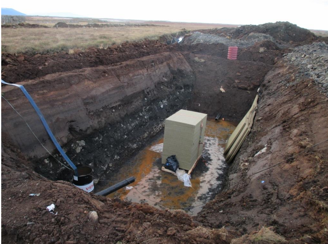
Mynd 4: Nýtt síubeð í undirbúningi. Veggir verða klæddir með glerull sem hlífir dúknum sem lagður verður þar yfir. Úr fjarlægari enda síubeðsins mun útrás opnast út í skurðinn sem liggur meðfram henni vinstra megin. (Ljós. S.G. 26. sept. 2016).
