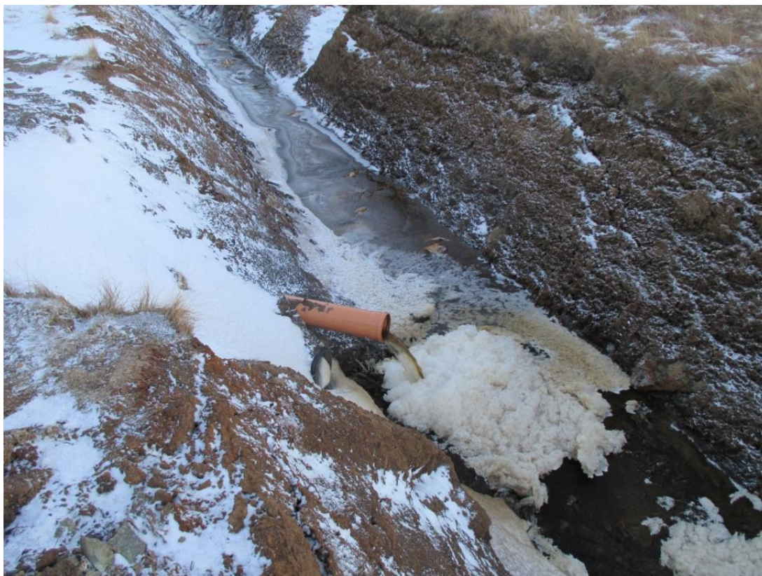
Mynd 11: Nýja yfirfallið. Rennsli um 2,6 l/sek, vatnið dökkt og mikil Froðumyndun. (Ljósm. S.G. 21. des. 2016).
