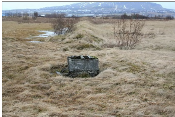
Mynd 13. Brunnhús (1896-113), horft í suður.
