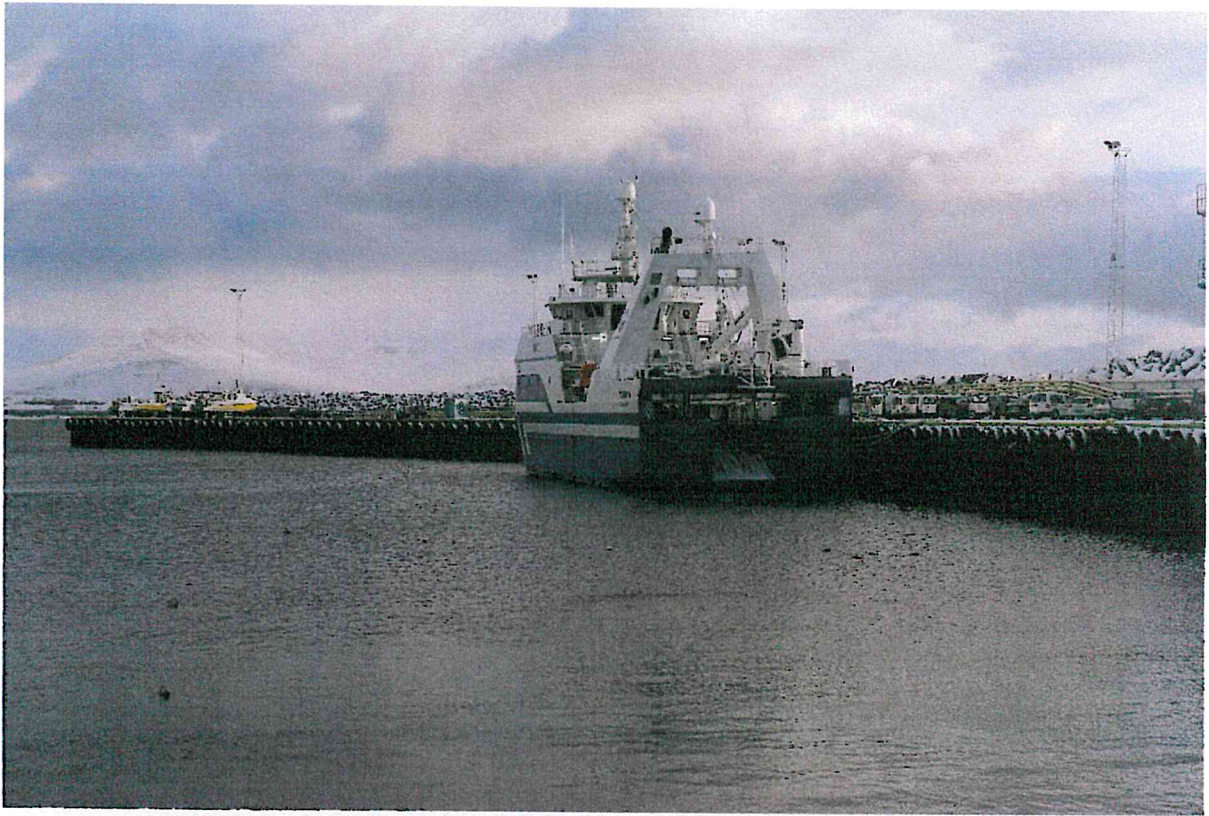
Mynd 3 Horft eftir aðalhafnargarði til austurs.
